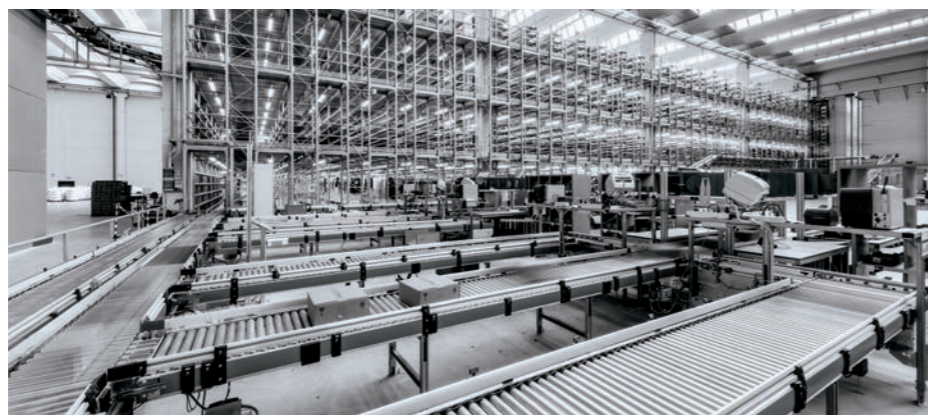
L'impianto Connecthub di Mantova
